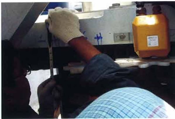
आयनॉक्स 200 kW पवन टरबाइन के लिए नैसल उपकरणिकरण कार्य
