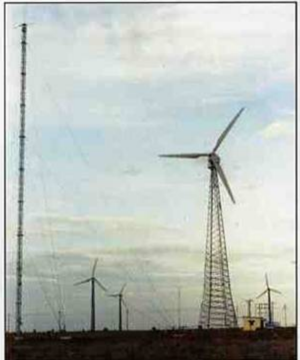
कयाथार में पवन टरबाइन के परीक्षण केन्द्र का एक दृश्य जिसमें परीक्षण के अंतर्गत पवन टरबाइन, नियंत्रण कक्ष, पवन मॉनीटरिंग मास्ट दिखाई दे रहे हैं।
