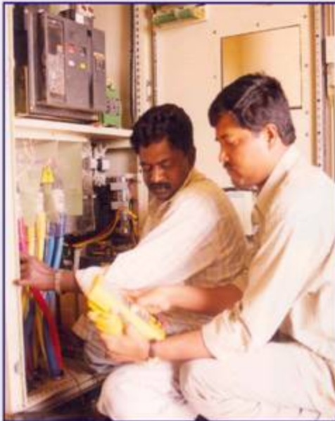
जैसलमेर में सुजलॉन 1000 किवा. पवन टरबाइन पर इंस्ट्रुमेंटेशन की जांच
