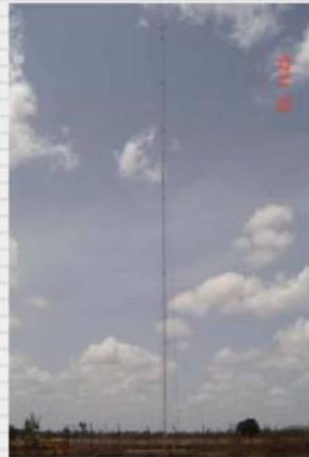
चित्र 12 : मिडकनहल्ली, कर्नाटक में 50 मी. ऊंचा पवन मानीटरिंग मास्ट
