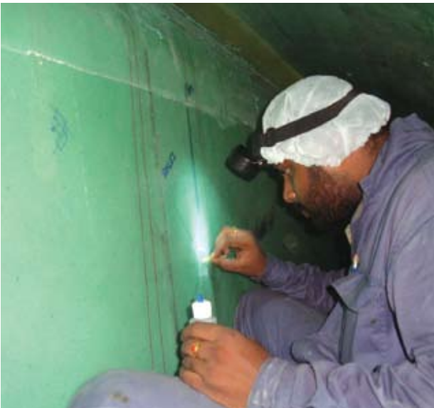
मेसर्स विण्डेड के 1000 kW ब्लेड के स्टेडन गेजिंग केलिए स्टेटिक ब्लेड परिक्षण
