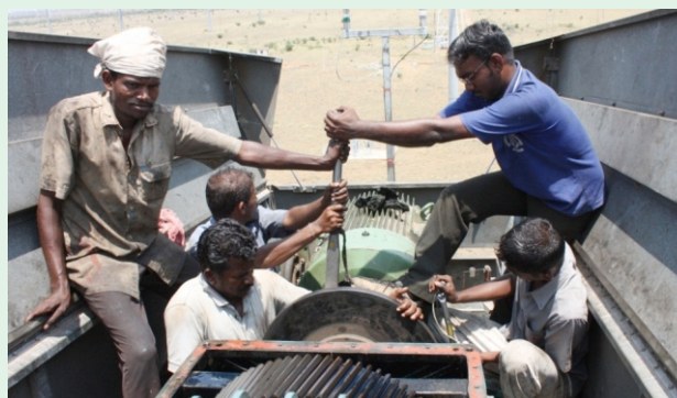
डबल्यूटीआरएस कयथार में अनुसंधान एवं किस खेत का प्रचालन एवं रखरखाव – जनरेटर की बियरिंग को फिक्स किया जा रहा है
