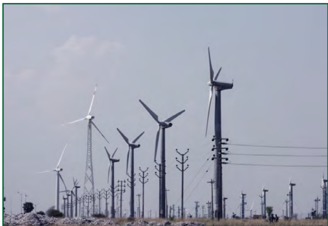
डब्ल्यूटीआरएस, क्याथार में 200 किलोवाट के माइक्रॉन पवन विद्युत जेनरेटर
