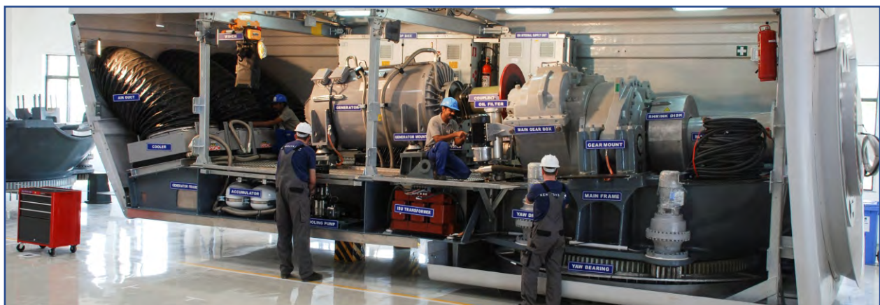
2 मेगावाट प्रायोगिक / अनुसंधान पवन टरबाइन मॉडल पर ड्राइव ट्रेन
