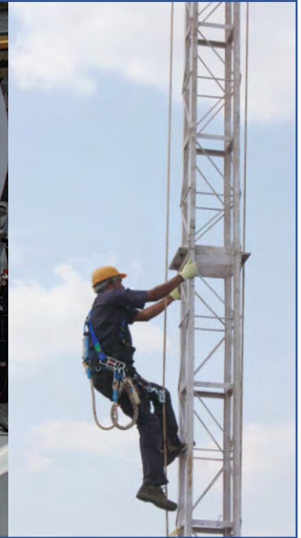
1000 किलोवॉट- एक्सोन टेक्नोलॉजी का मौसम मस्तूल उपकरणीकरण।
