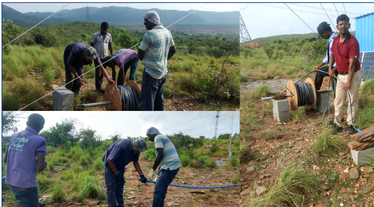
आंध्र प्रदेश राज्य के कडप्पा जिले, बडवल क्षेत्र में ( धीमी पवन ऊर्जा गति मौसम की अवधि में) मॉडल जीई / 1700/103, 1700 किलोवॉट के पवन ऊर्जा टरबाइन-शक्ति वक्र मापन का कार्य ।
