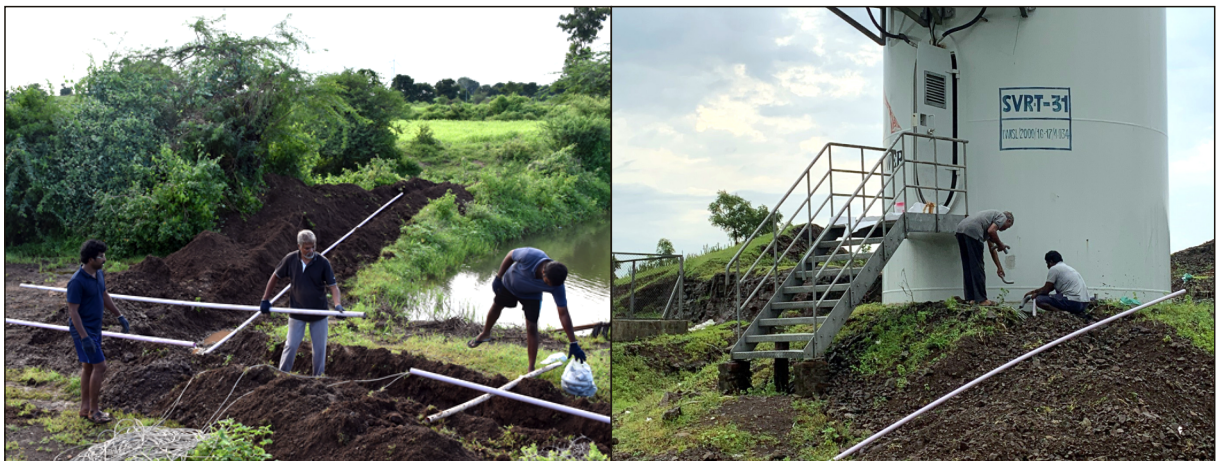
पावर कर्व मेजरमेंट (पीसीएम) मॉडल के लिए केबल बिछाने का कार्य - आईनोक्स डीएफ/2000/113, 2000 किलोवाट, अमरेली जिला गुजरात के सावरकुंडला में मेसर्स इनोक्स विंड लिमिटेड से एक पवन ऊर्जा टरबाइन
