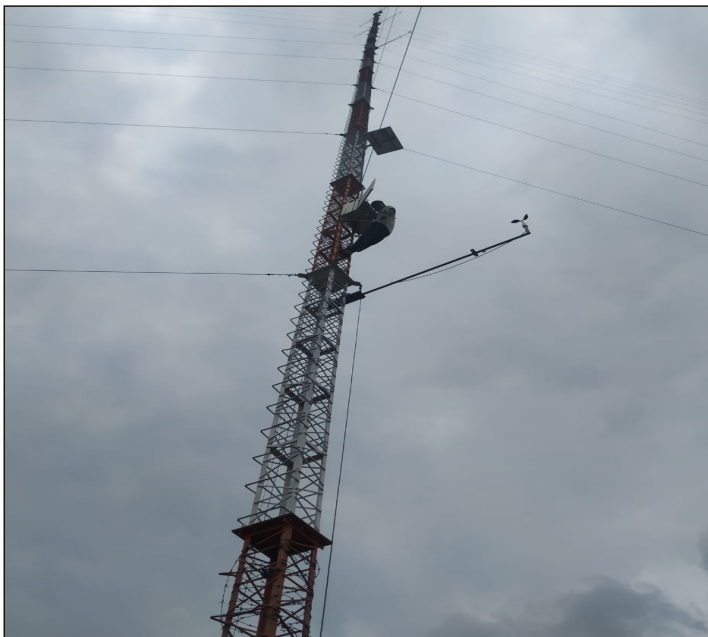
Pic चित्र: नरेंद्र साइट, धारवाड़ कर्नाटक जिला में 100 मीटर एकीकृत पवन-सौर संसाधन मूल्यांकन स्टेशन
