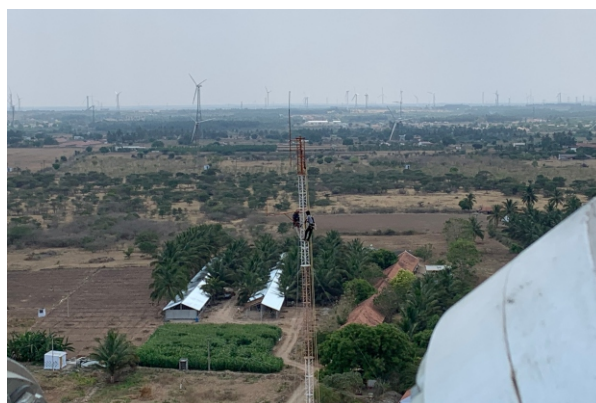
मेट मास्ट उपकरणिकरण
