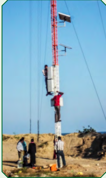
एन्नोर पोर्ट पर 80 मीटर मस्तूल की संस्थापना
