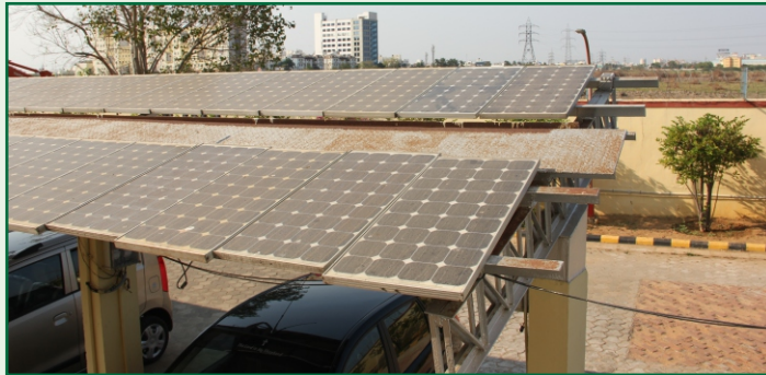
वर्धा चक्रवात और मरम्मत के पश्चात कार गैरेज की छत पर संस्थापित किए गए 15 किलोवाट के सौर ऊर्जा पैनल
