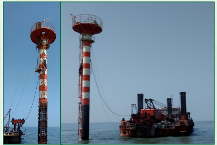
प्लेटफार्म बोट लैंडिंग और रेस्टिंग प्लेटफार्म
